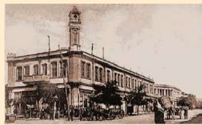
Най-старата сграда на Бургаската община, изгоряла при пожар на 17 август 1899.
