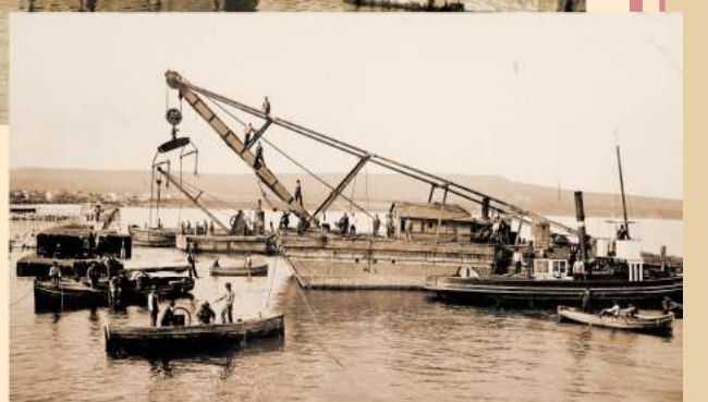
Момент от строителството на Пристанище Варна. На бора на плаващия кран „Напредък“ е застанал пристанищният влекач „Труда“, а в ляво се виждат две водолазни лодки. Източник: Военноморски музей - Варна.
